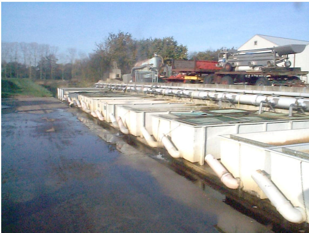
Waterloop via bekkens buiten, van de vijvers naar de afvoersloot.
