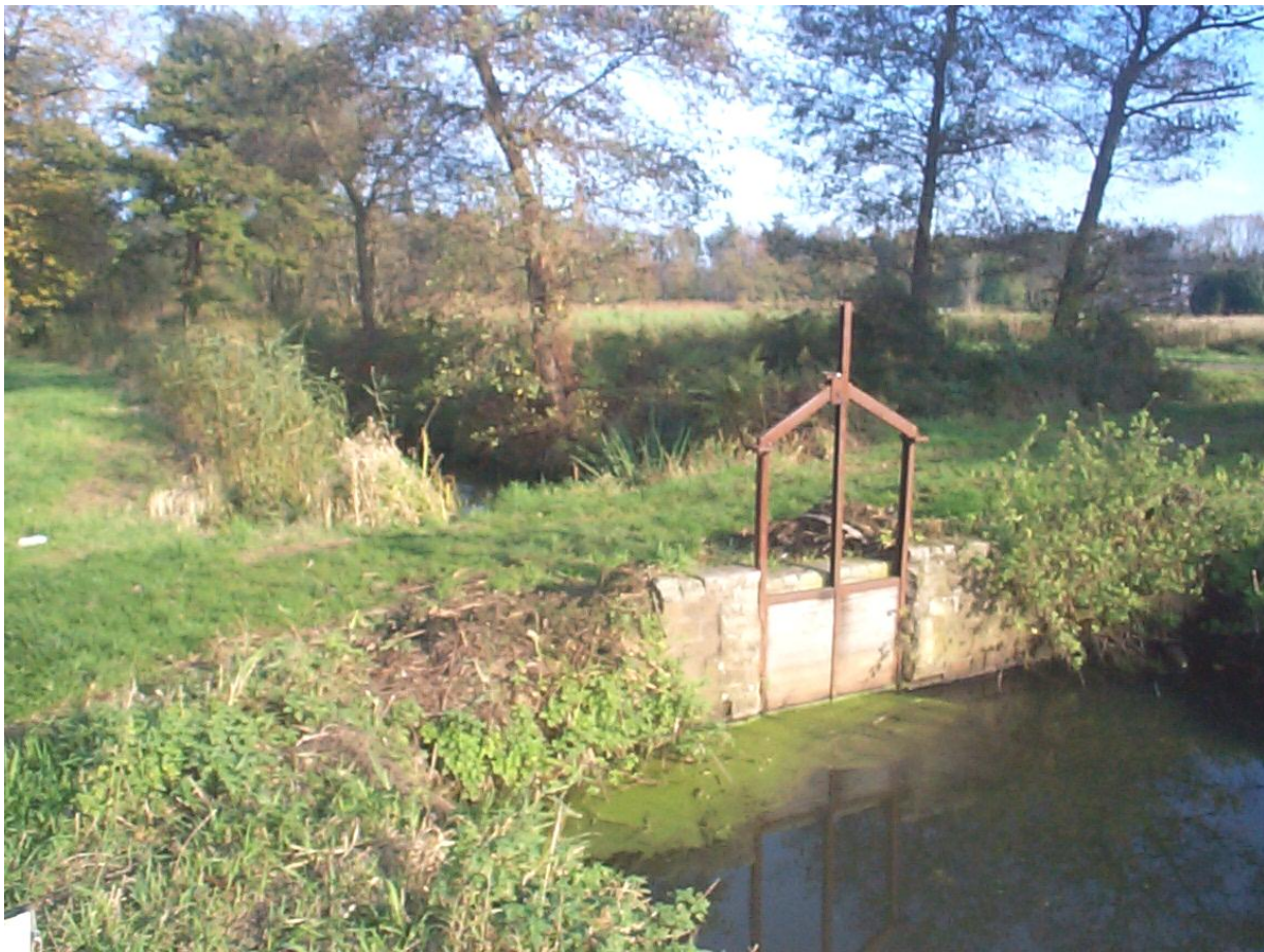
De waterstand van de bronzen sloot kan d.m.v. een kleine stuw worden geregeld bij 3 bruggen.
