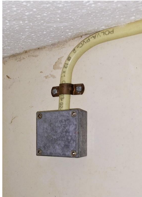
20a. DS1820 digitale temperatuur sensor ingebouwd in metalen behuizing tegen het plafond van de viskamer t.b.v. aflezen, instellen en regelen van de temperatuur.
